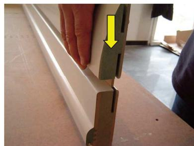
S'assurer du bon contact entre le dormant et l'extension et procéder au vissage des languettes sur le dormant et les extensions à l'aide de vis 4x25 ; un vissage en 3 zones réparties sur la hauteur du montant.
