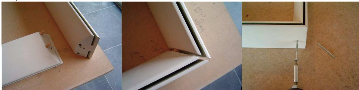
Equiper le dormant (colis 1, 2, 3 ou 4) correspondant avec les languettes fournies : les disposer dans la rainure prévue à cet effet, sur le coté opposé au joint du dormant.
