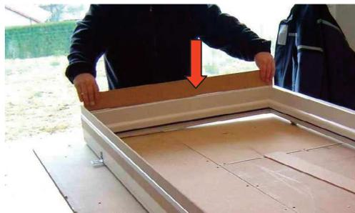
Assembler l'extension préparée précédemment sur le dormant équipé de ses languettes
