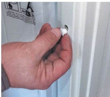
Pré-perçage usine
